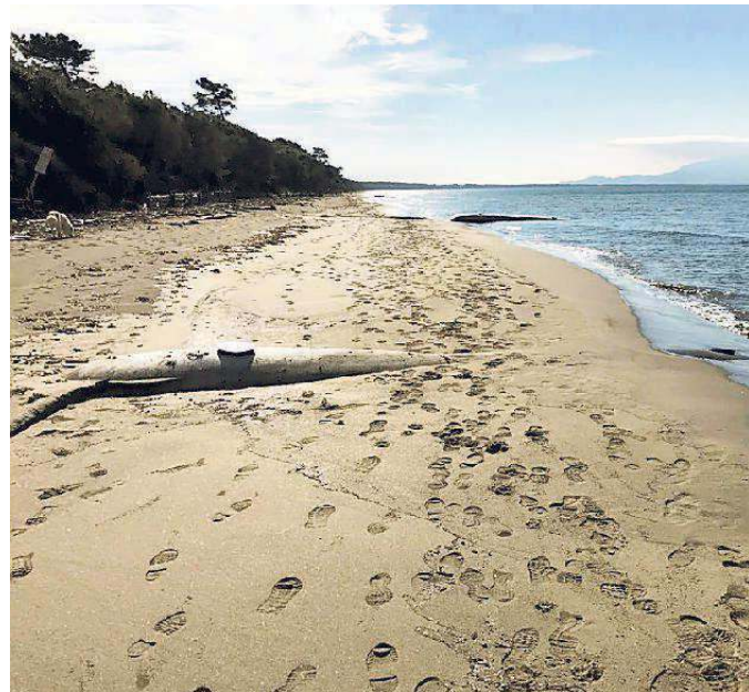
La spiaggia che ha riconquistato spazio "dopo" l'installazione dei geotubi
